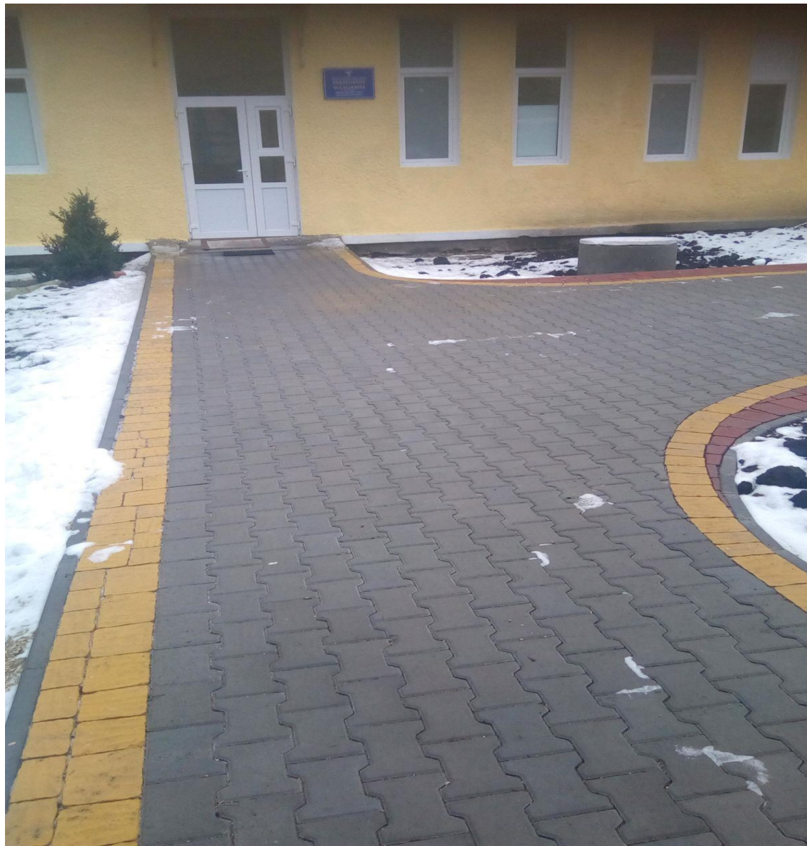
▶ Капітальний ремонт центральної доріжки Скалатської комунальної районної лікарні в м.Скалат по вул.Л.Курбаса,36 Підволочиського району Тернопільської області
